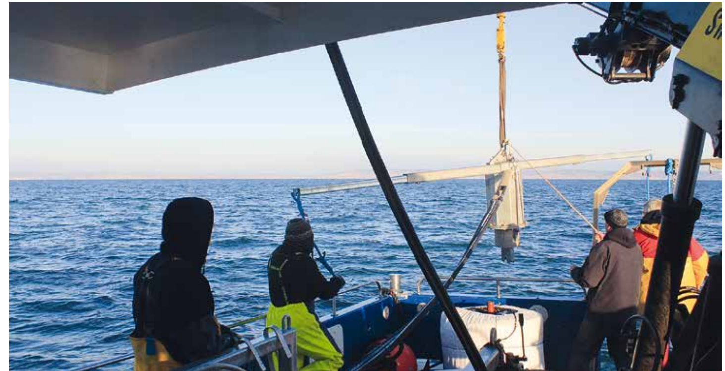
De eerste schroefankers worden geplaatst.
