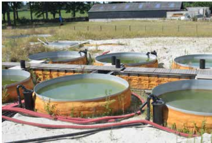
De buitenvijvers en verbindingsskanalen worden volledig geïsoleerd.
